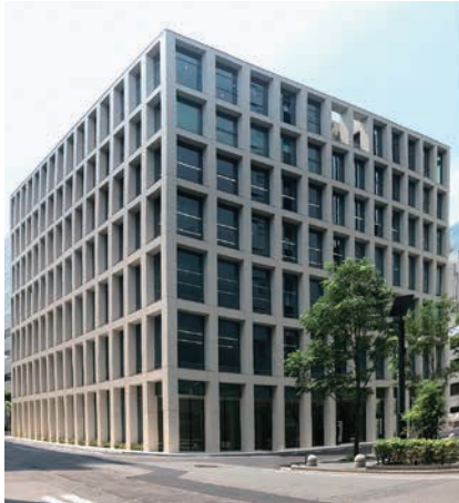
新「全国信用組合会館」2019年7月31日竣工
